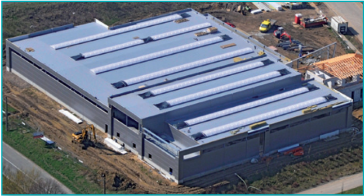
Mars 2009: nouvelle usine Reddy en construction. Maart 2009: de nieuwe Reddy fabriek in aanbouw.
